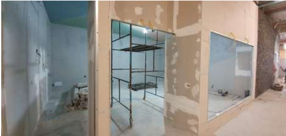
Sistema construtivo drywall Foto: Ciclo Life
